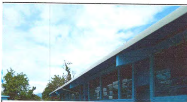
Foto 6: Trabajo finalizado de reparacion de canales y vajadas de agua
