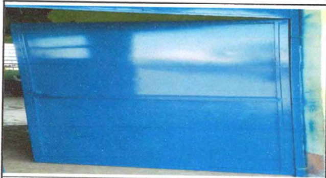
Foto 3: Trabajo finalizado de repacion de puertas de las aulas
