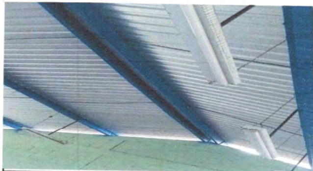
Foto 2: Lijado, pintado y resoldado de estructura finalizado
