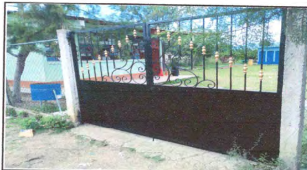
Foto 8: trabajo finalizado de sustitucion de porton
