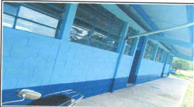
Foto 7: trabajo finalizado de pintura en muros interiores y exteriores
