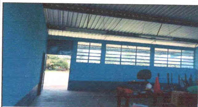
Foto 5: trabajo finalizado de sustitucion de vidrios en ventanales
