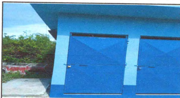
Foto 4: trabajo finalizado de repacion de puertas de los baños
