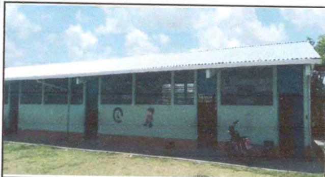
Foto1: Montaje de techo finalizado
