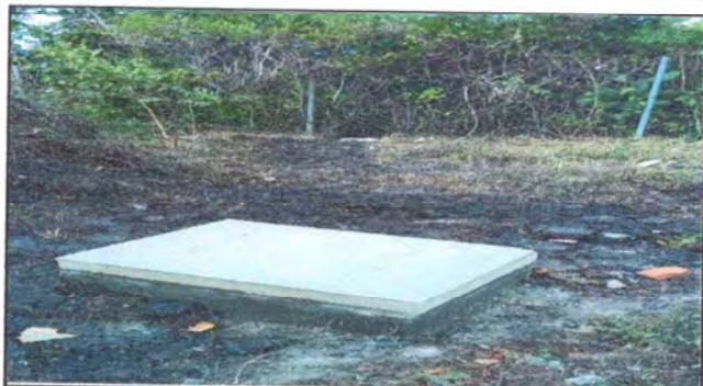
Foto 9: trabajo finalizado de reparacion de drenaje
