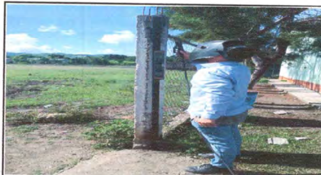
Foto 8: trabajando en la sustitución del portón
