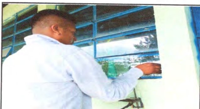
Foto 5: trabajando en la reposicion de vidrios
