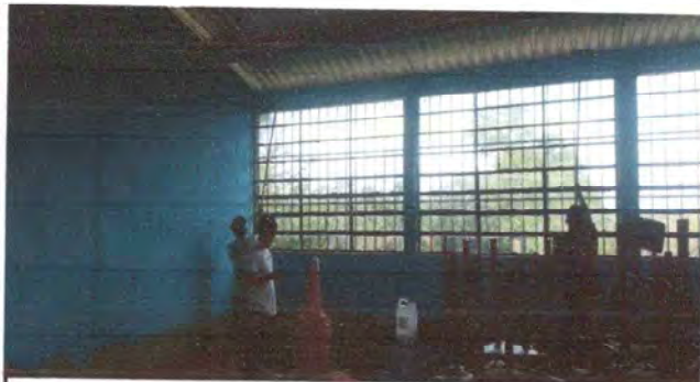
Foto 7: trabajando en la pintura de muros interiores y exteriores
