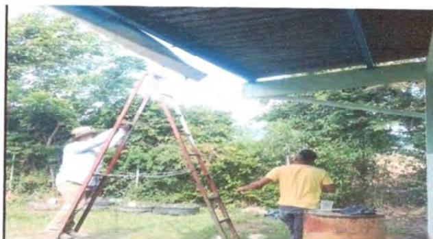
Foto 6: Trabajando en la repacion de canales y vajadas de agua
