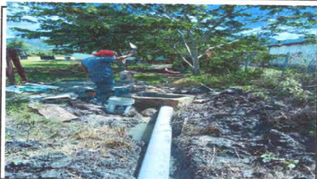
Foto 9: trabajando en la reparación de red de drenaje
