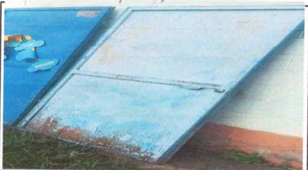
Foto 3: trabajando lijado y reparación de puertas de aulas
