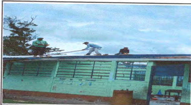
Foto1: montaje de techo
