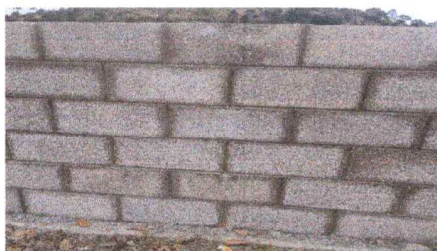
Foto 3: SUSTITUCION MURO PERIMETRAL BLOCK CISADO MAS COMUNAS DE CONCRETO ENSAB IETADAS
