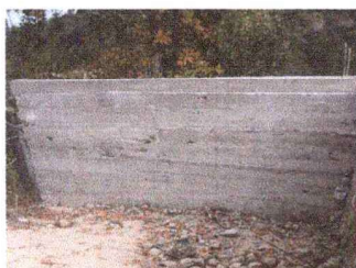
Foto 5: SUSTITUCION DE MURO DE CONCRETO ARMADO
