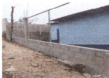
Foto 2: SUSTITUCION DE CERCO PERIMETRAL CON BLOCK Y MALLA
