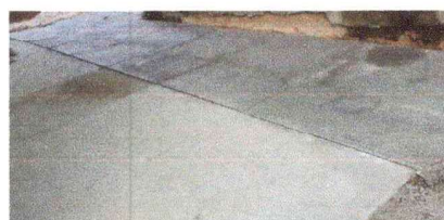
Foto 4: SUSTITUCION DE LOSA DE PATIO INCLUYENDO FUNDICION Y ACABADO
