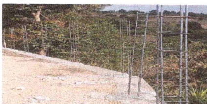
Foto 3: SUSTITUCION MURO PERIMETRAL BLOCK CISADO MAS COMUNAS DE CONCRETO ENSAB IETADAS
