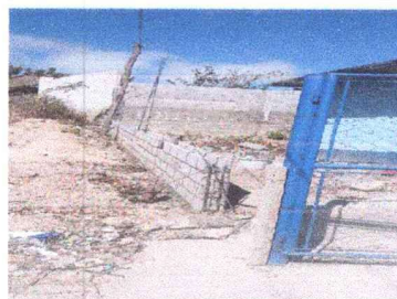
Foto 2: SUSTITUCION DE CERCO PERIMETRAL CON BLOCK Y MALLA
