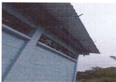
Foto 1: CANALES Y BAJADAS DE AGUA PROVIAL
