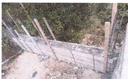
Foto 5: SUSTITUCION DE MURO DE CONCRETO ARMADO
