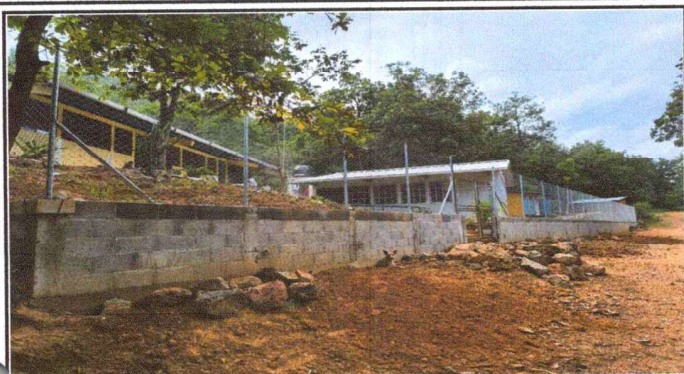
Foto1: Cerco o muro perimetral finalizado.
