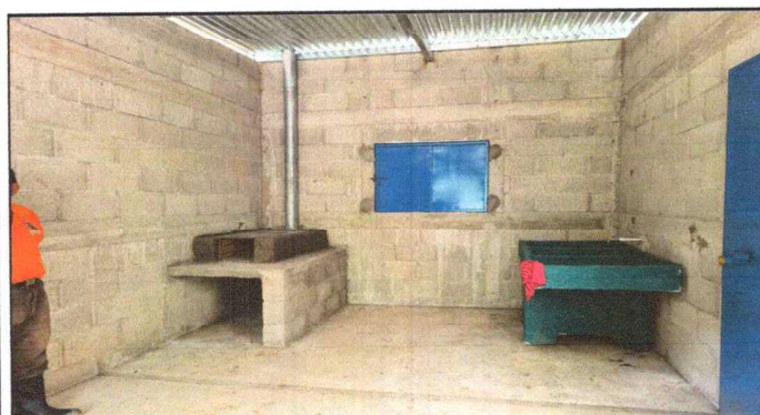
Foto 3: Area de cocina finalizada.
