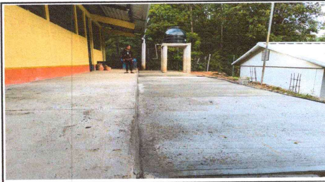
Foto 2: Losa de patio finalizada.
