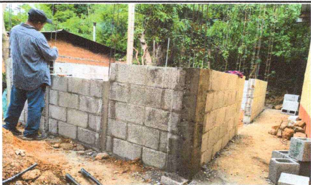
Foto 3: Sustitución area de cocina.
