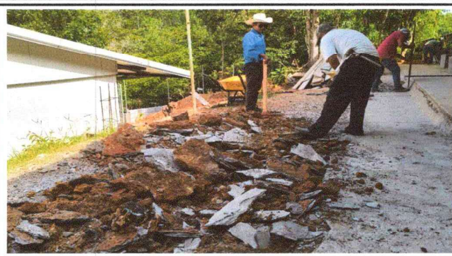
Foto 2: Sustitución de losa de patio
