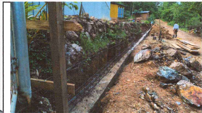
Foto1: Sustitución de cerco o muro perimetral.
