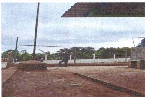
Foto 1: reparación de cerco perimetral con malla
