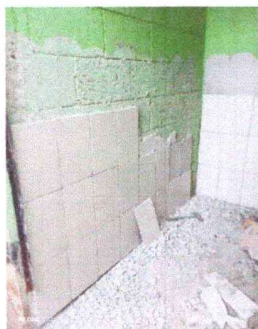
Foto; 3 instalacion de azulejos para colocar los baños
