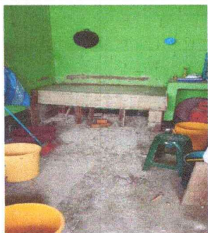
Foto1: comenzando la cocina rural
