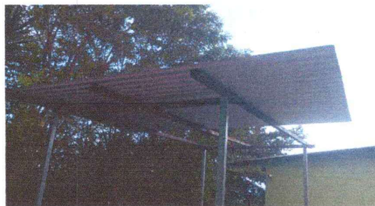
foto 6: colocación de lamina en la cocina
