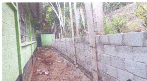
Foto: 4levantamiento de muro perimetral
