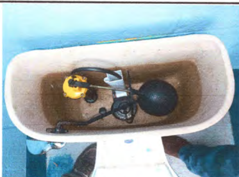
Foto 5: Finalización de reparación de sanitarios.
