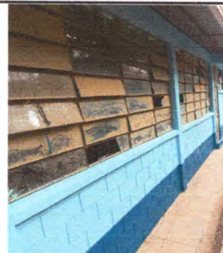
Foto 4: Finalización de pintura.
