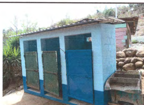
Foto 6: Finalización de techos de sanitarios.
