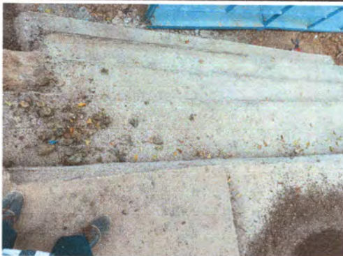
Foto 3: Finalización de gradas
