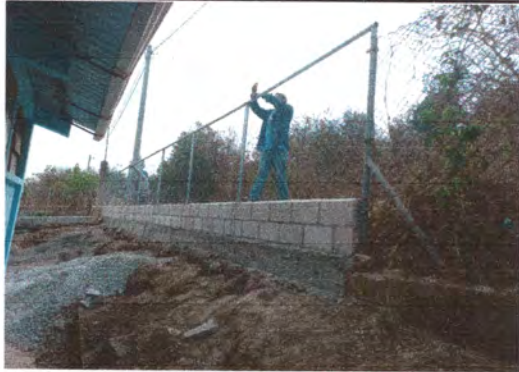
Foto1: Finalización de muro de maya.
