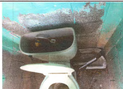
Foto 4: Reparación de sanitarios.
