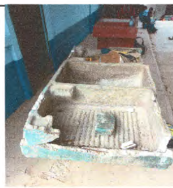
Foto 6: Reparación de pila
