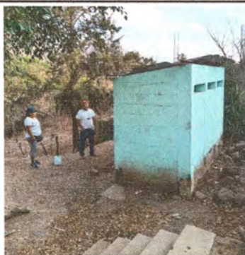
Foto 5: Reparación de los techos de los sanitarios.
