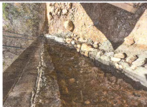
Foto 2: Reparación de muro de contención.
