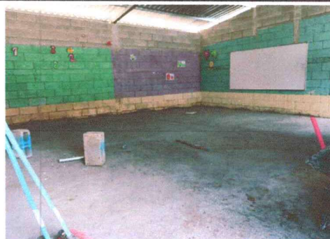
Foto 4: Piso de cemento finalizado.
