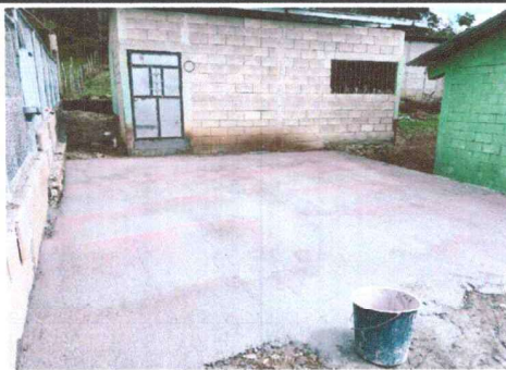
Foto 5: Fundición de los 186 metros cuadrados.
