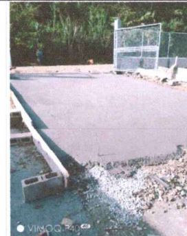
Foto 4: Fundición de losa.
