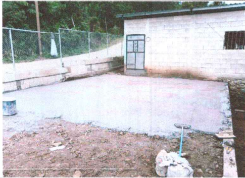
Foto1: En proceso de losa.
