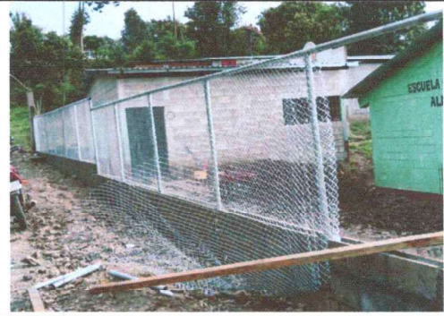
Foto 2: En proceso a pario de losa.
