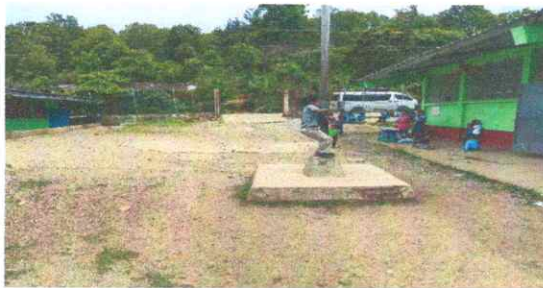
LOSA DE PATIO DETERIORADA (SUSTITUCION)
