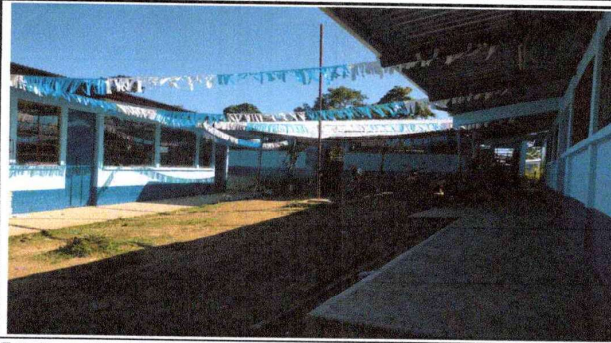
Foto1: sustitucion de pintura Base Agua
