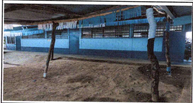
Foto 2: reparacion de Puertas en area de aulas.
