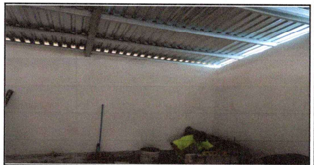
Foto 6: sustitucion de repello y cernido
