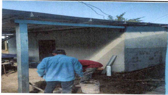
Foto1: sustitucion de lamina Troquelada
