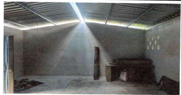
Foto 2: sustitucion de repello y cernido
