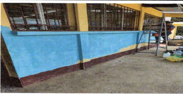
Foto 5: sustitucion de pintura base agua
