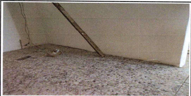
Foto 4: sustitucion de piso de granito
