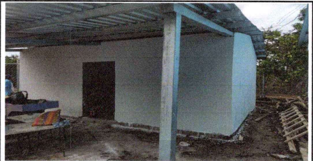
Foto 6: fundicion de losa para patio
