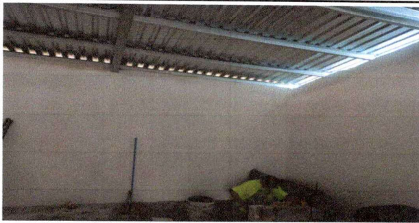
Foto 3: sustitucion de area de cocina
