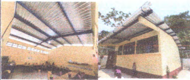
Foto1: Techo nuevo de aula
