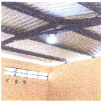
Foto 3: Instalacion de energia y focos nuevos
