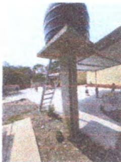
Foto 5: tubería de baño y deposito reparada
