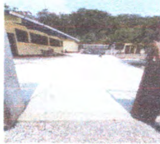
Foto 2: Losa de patio terminada
