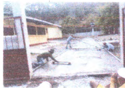
Foto 2: Proceso de fundicion losa de patio
