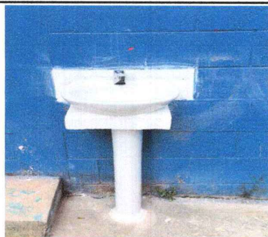
Foto 3: Sustitución de lavamanos con pedestal.
