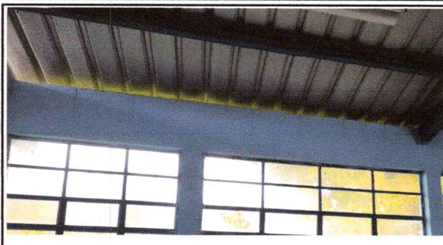
Foto 2: Sustitución de vidrios medidas típicas.
