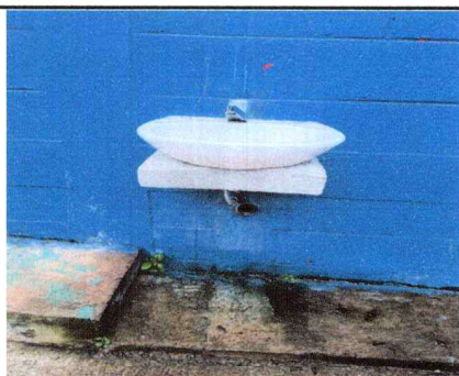
Foto 3: Sustitución de lavamanos con pedestal.
