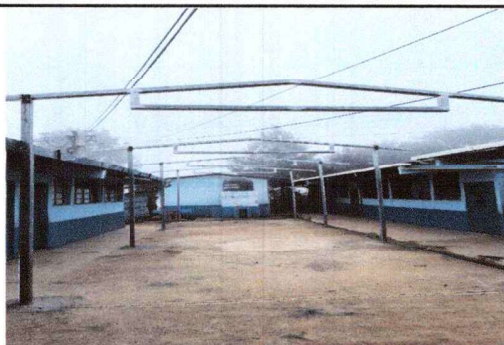
Foto1: Desmontaje de lámina acanalada y sustitución de la misma por lámina troquelada calibre 26, instalación de soporte de estructura, así mismo sustitución de la escritura de madera a estructura de metal.
