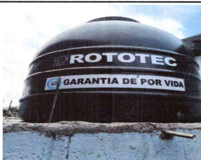
Foto 5: Sustitución de depósito de agua tipo rotoplas de 1200 litros.
