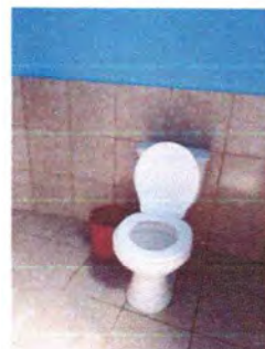
Foto 8: Sustitución de servicios sanitarios
