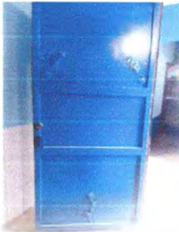
Foto 3: Sustrucción de puerta de aula.
