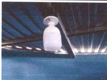
Foto 13: Reparación de sistema eléctrico (sustitución).
