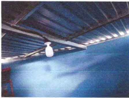
Foto 1: Sustrucción Cubierta de lamina.
