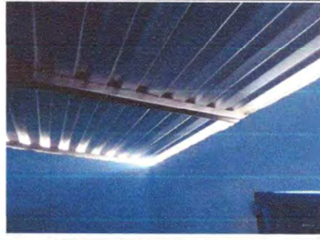
Foto 2: Sustrucción Estructura de techo
