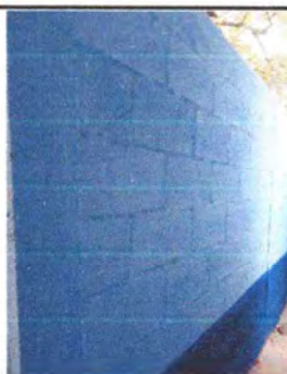
Foto 11: Cerco o muro perimetral (sustitución con block).
