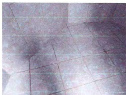
Foto 9: Sustitución de azulejo.
