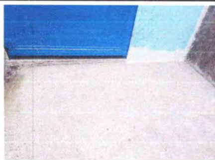
Foto 12: Losa de patio.
