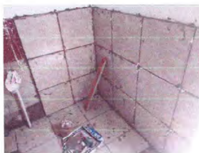
Foto 9: Sustitución de azulejo.
