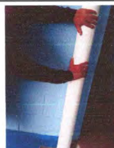
Foto 6: Sustitución de canales y bajadas de agua pluvial
