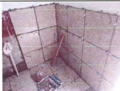
Foto 5: Sustitución de piso cerámico
