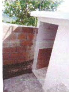
Foto 4: Sustitución puerta de baño.
