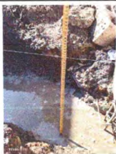
Foto 11: Cerco o muro perimetral (sustitución con block).
