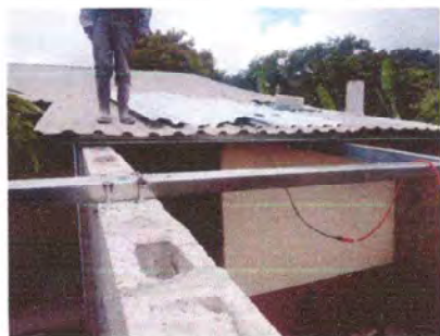
Foto 1: Sustitución Cubierta de lamina.
