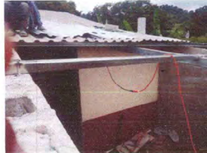
Foto 2: Sustitución Estructura de techo
