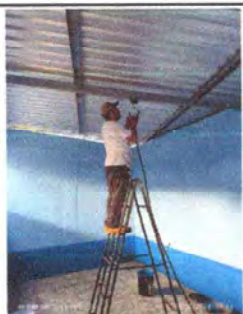
Foto 13: Reparación de sistema eléctrico (sustitución).
