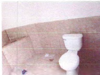
Foto 8: Sustitución de servicios sanitarios
