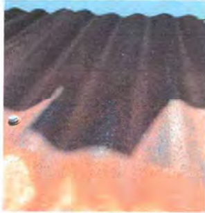
Foto 1: Sustitución Cubierta de lamina.
