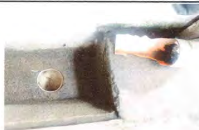
Foto 6: Sustitución de canales y bajadas de agua pluvial
