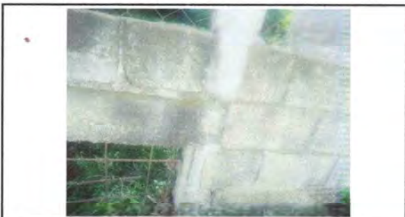
Foto 11: Cerco o muro perimetral (sustitución con block).
