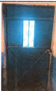
Foto 3: Sustitución de puerta de aula.
