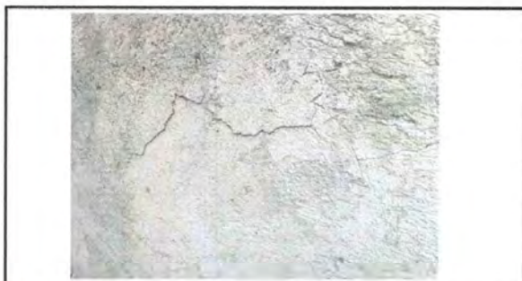
Foto 12: Losa de patio.
