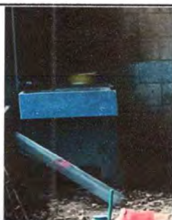
Foto 15: Reparación de área de cocina (sustitución).
