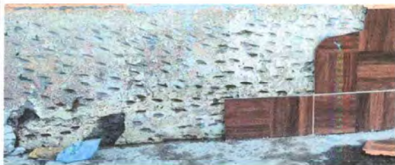
Foto 5: Sustitución de piso cerámico
