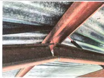
Foto 2: Sustitución Estructura de techo
