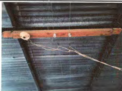
Foto 13: Reparación de sistema eléctrico (sustitución).
