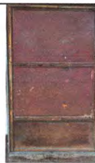
Foto 4: Sustitución puerta de baño.
