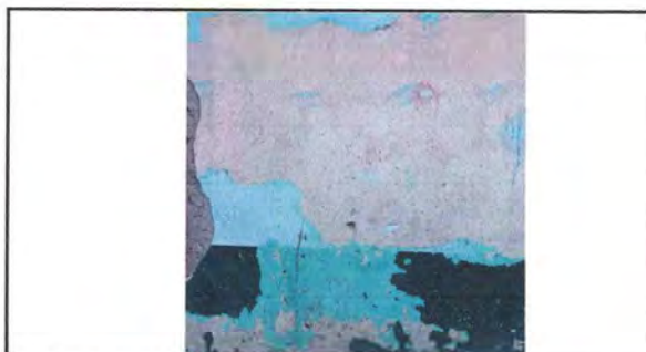
Foto 7: Pintura en muros.
