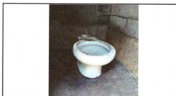
Foto 8: Sustitución de servicios sanitarios
