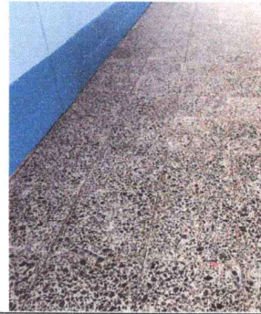
Foto 2: Piso Granito finalizado
