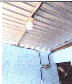
Foto 6: Sistema eléctrico reparado
