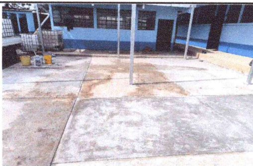
Foto 5: Losa de Patio finalizada
