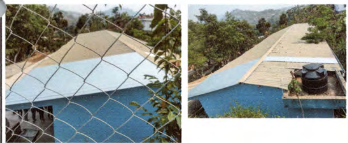
Foto 5: Se colocaron láminas nuevas en el techo de los baños
