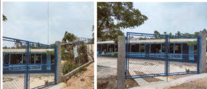
Foto 6: Se finalizó con la malla perimetral y el portón
