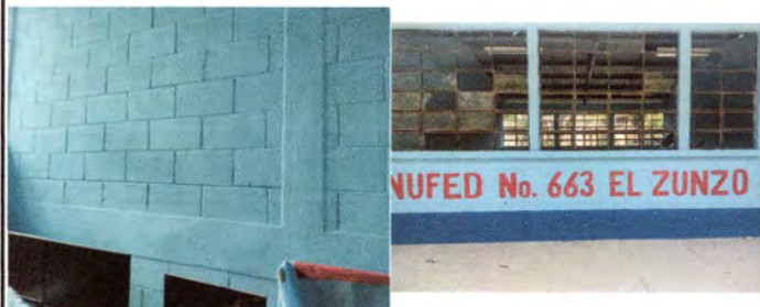
Foto1: Se finalizó de pintar los muros interiores y exteriores
