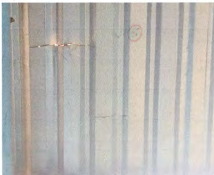
Foto1: Se observó agujeros en la lámina
