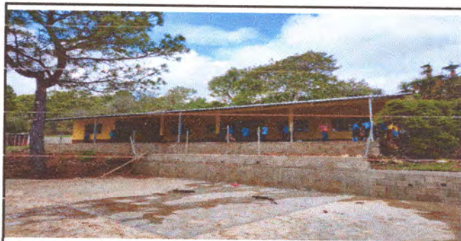
Foto: 6: Sustitución de cubierta de lamina por lamina troquelada.
