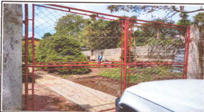
Foto4: Mantenimiento de portón principal, estructura y malla.
