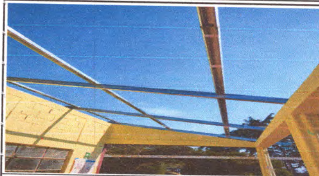
FOTO 2: Sustitución de estructura de techo de madera por estructura de techo de metal.
