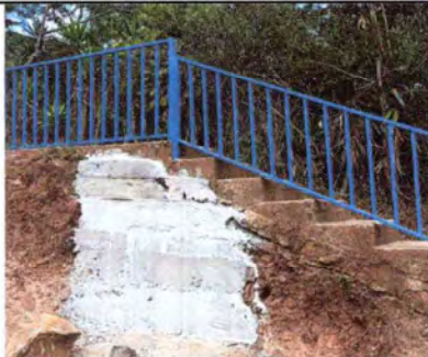
Foto 9: Sustitución de muro de concreto en gradas
