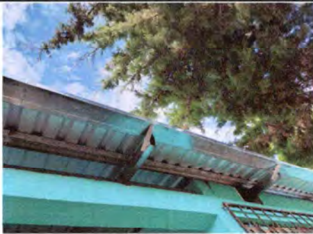
Foto 3: Sustrucción de Canales
