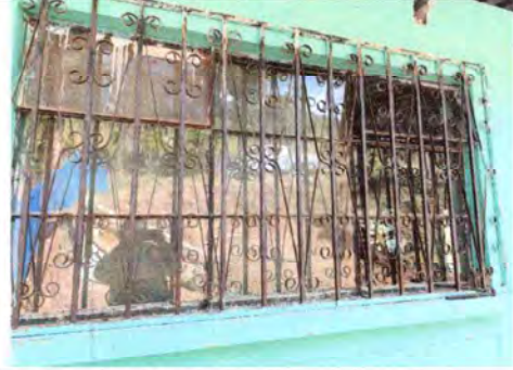
Foto 2: Sustrucción de Vidrios
