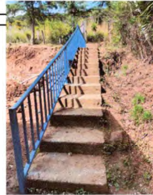
Foto 4: Sustrucción de Baranda en gradas
