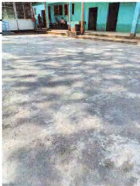
Foto 5: Sustrucción de losa de patio
