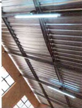
Foto 7: Sustitución de lamparas
