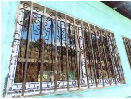
Foto1: Sustrucción de Ventanas
