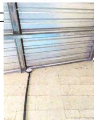
Foto 6: Sustrucción de cableado
