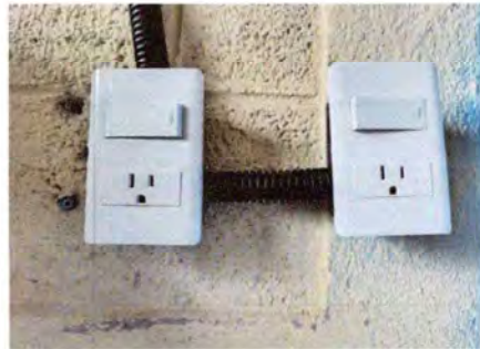
Foto 8: Sustitución de tomacorrientes
