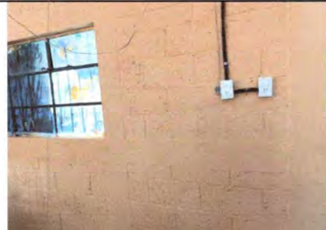
Foto 10: Sustitución de Pintura
