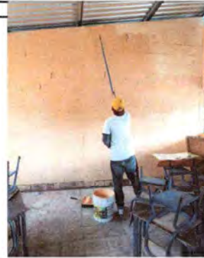
Foto 10: Sustitución de Pintura
