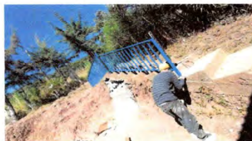
Foto 4: Sustitución de Baranda en gradas
