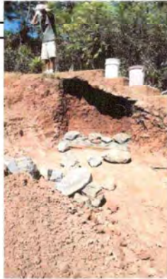
Foto 9: Sustitución de muro de concreto en gradas
