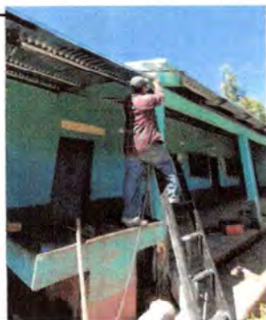
Foto 3: Sustitución de Canales
