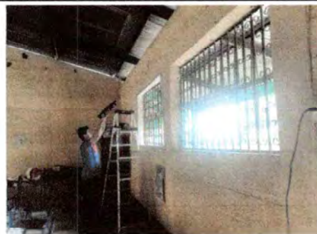
Foto 2: Sustitución de Vidrios
