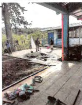
Foto 5: Sustitución de losa de patio
