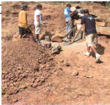
Foto 10: Sustitución de muro de concreto en gradas
