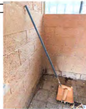
Foto 11: Sustitución de Pintura
