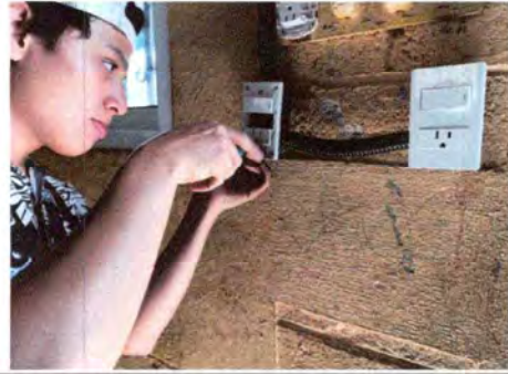
Foto 8: Sustitución de tomacorrientes
