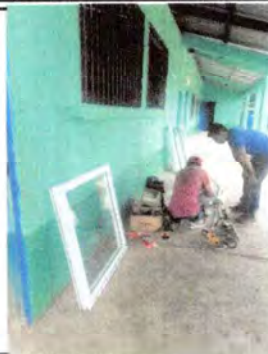
Foto1: Sustitución de Ventanas
