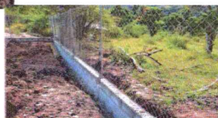
FOTO 2: CERCO O MURO PERIMETRAL FINALIZADO
