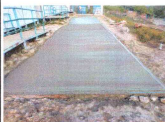
Foto3: LOSA DE PATIO TERMINADO
