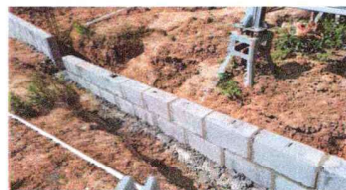
Foto 2: MURO PERIMETRAL EN PROCESO DE REPARACION
