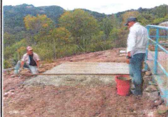
Foto 3: Sustitución de losa de barro
