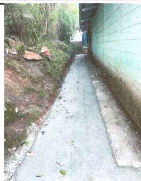
Foto 2: FUNDICION DE CUNETA DE CONCRETO
