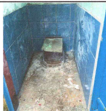
Foto 4: INNSTALACION DE AZULEJO
