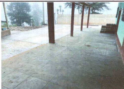
Foto 5: FUNDICION DE LOZA DE CONCRETO
