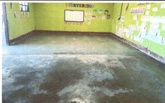
Foto1: FUNDICION DE PISO DE CONCRETO TIPO ALIZADO
