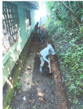
Foto 2: PRERPARANDO TERRENO PARA LA FUNDICION DE CUNETAS
