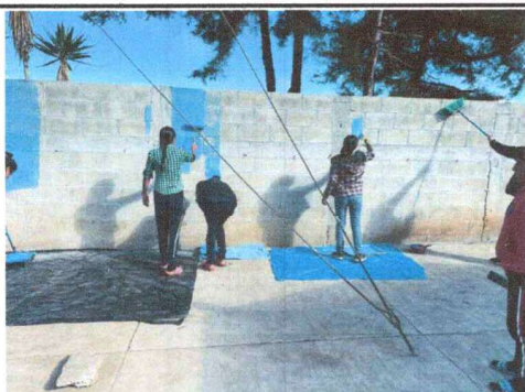
Foto 3: INICIANDO CON PINTURA
