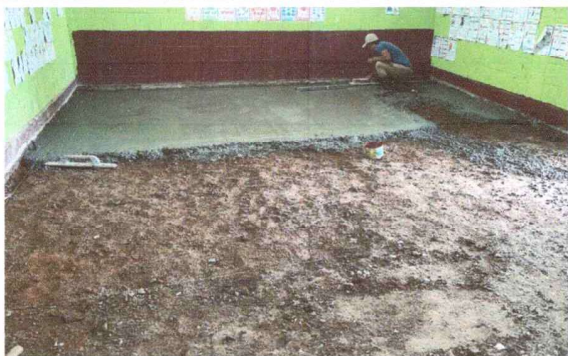
Foto 1: INSTALACION DE PISO DE CONCRETO TIPO ALIZADO
