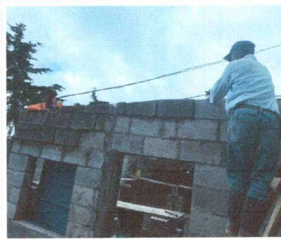
Foto 6: AREA DE CUMBRERA PARA LA INSTALACION DE TECHO DE LAMINA
