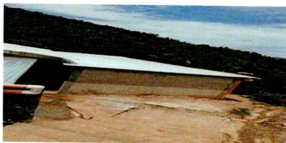
cambio de laminas del techo
