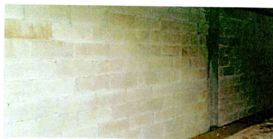
reparacion de paredes
