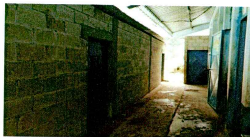
reparacion de paredes
