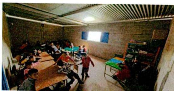
instalacion de estructura metalica del techo
