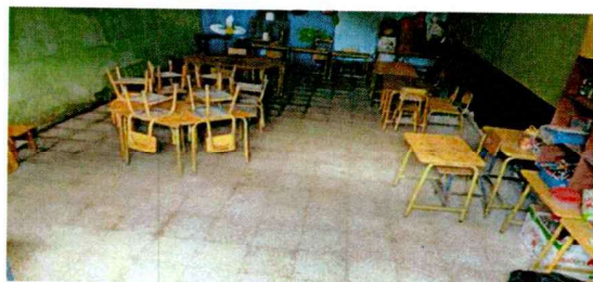
instalacion de piso de granito
