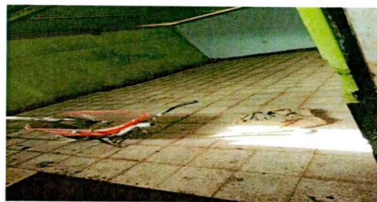
instalacion de piso de granito
