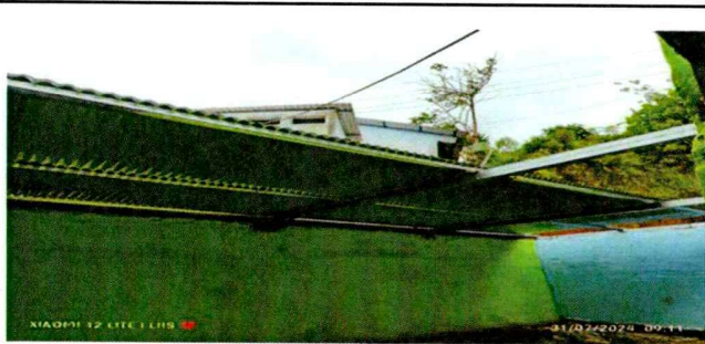
cambio de estructura de techo
