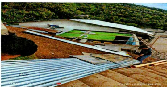
cambio de cubierta de lamina
