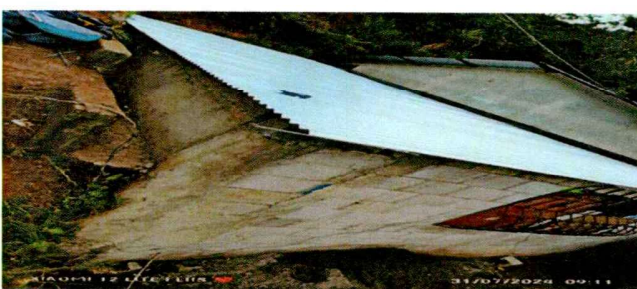
reparacion de paredes
