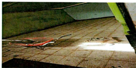
instalacion de piso
