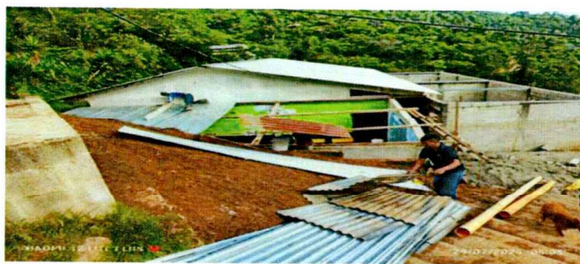
cambio de cubierta de lamina
