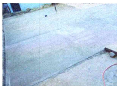
Foto 6: REPARACIÓN LOSA DE PATIO
