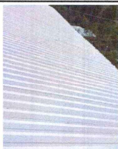
Foto 3: SUSTITUCIÓN DE LÁMINA TROQUELADA CALIBRE 26
