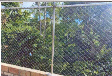
Foto 1: SUSTITUCIÓN DE CERCO PERIMETRAL CON BLOCK Y MALLA
