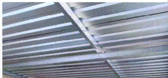
Foto 4: SUSTITUCIÓN DE ESTRUCTURA DE TECHO
