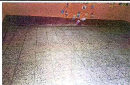
Foto 5: SUSTITUCIÓN DE PISO GRANITO
