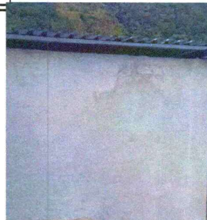
Foto 2: SUSTITUCIÓN DE REPELLO Y CERNIDO
