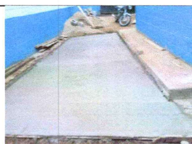
Foto 6: REPARACIÓN LOSA DE PATIO
