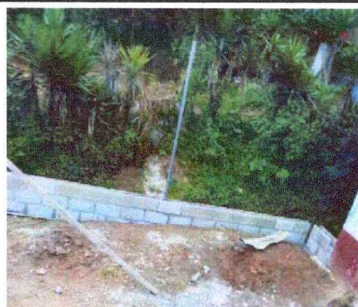
Foto 1: SUSTITUCIÓN DE CERCO PERIMETRAL CON BLOCK Y MALLA
