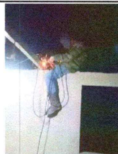
Foto 4: SUSTITUCIÓN DE ESTRUCTURA DE TECHO
