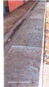
Foto 4: losa de patio, terminado.
