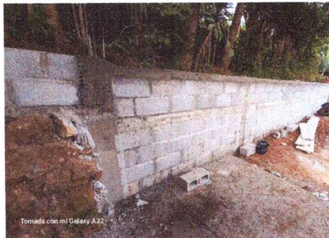
Foto 3: levantado de muro de contención, terminado
