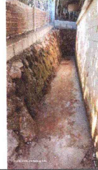
Foto 2: mantenimiento de cuneta, terminado
