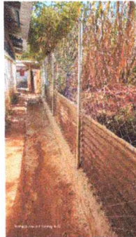
Foto 1: Circulación con malla, terminado
