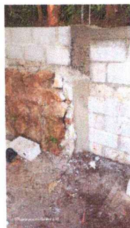
Foto 5: mantenimiento de muro perimetral, terminado
