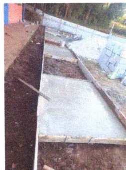
Foto 4: Se procede a colocar la losa de patio.
