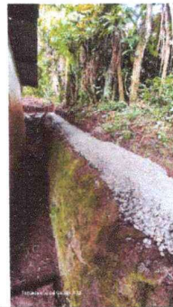
Foto 2: Se empieza a reforzar el muro de contención y muro perimetral.
