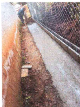
Foto 1: Se observa el mantenimiento de cuneta durante el proceso.
