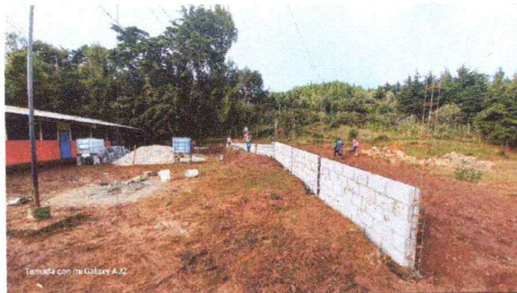
Foto 6: ya empieza a levantarse la circulación de la escuela con block
