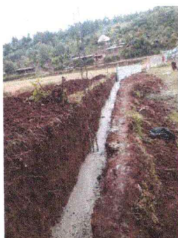
Foto 3: Se observa el inicio del levantado de la circulación para su sustitución.
