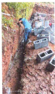
Foto 5: Sustitución de muro de Contención, levantado con block.
