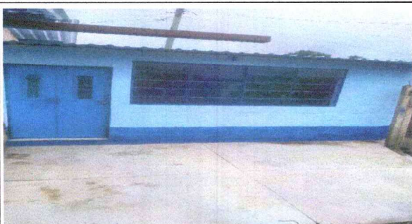
Foto 3: Sustitucion de ventanas
