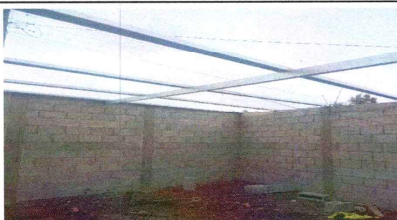
Foto 2: Sustitucion estructura de techo
