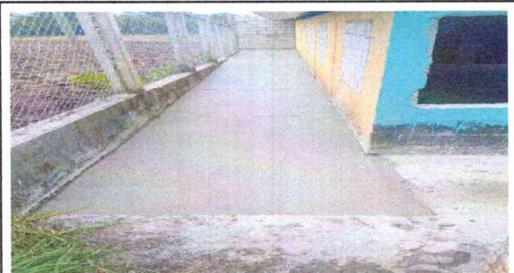
Foto 5: Sustitucion cuneta de concreto tipo baden incluye base, fundición y acabado final, sustitución de pintura base agua y de aceite.
