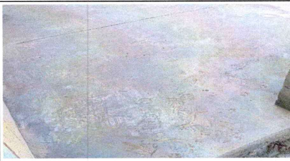
Foto 4: Sustitucion piso cemento(base, fundicion mas acabado)
