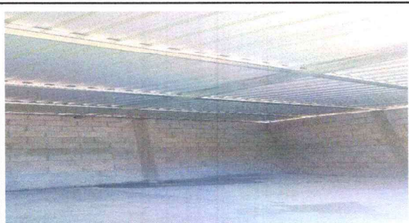
Foto1: Sustitucion lamina troquelada calibre 26
