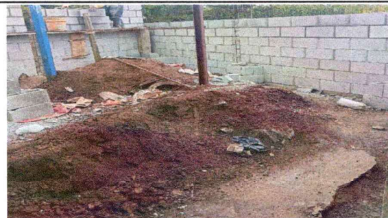
Foto 4: Sustitucion piso cemento(base, fundicion mas acabado)
