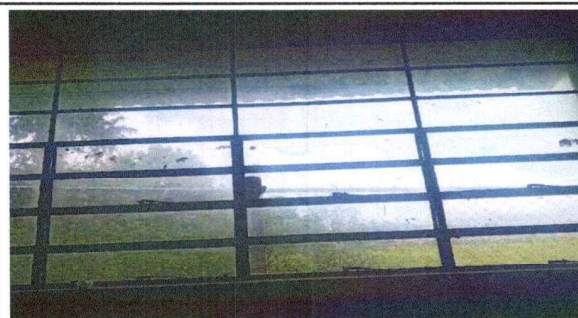
Foto 3: Sustitucion de ventanas
