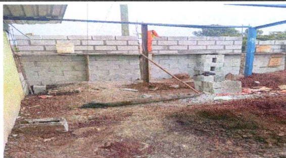
Foto 2: Sustitucion estructura de techo
