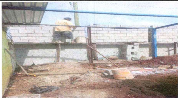
Foto1: Sustitucion lamina troquelada calibre 26
