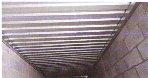
Foto1: CUBIERTA DE LÁMINA
