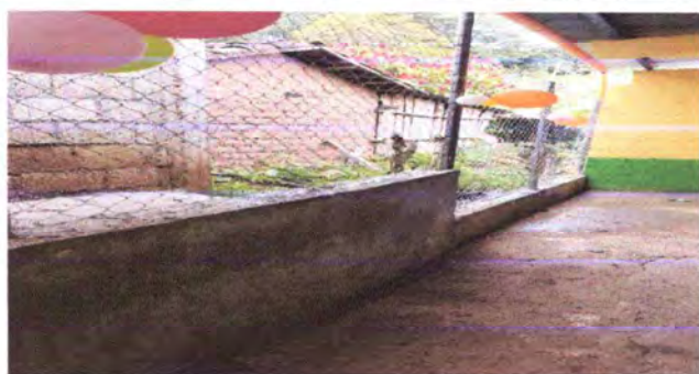
Foto 3: CERCO O MURO PERIMETRAL
