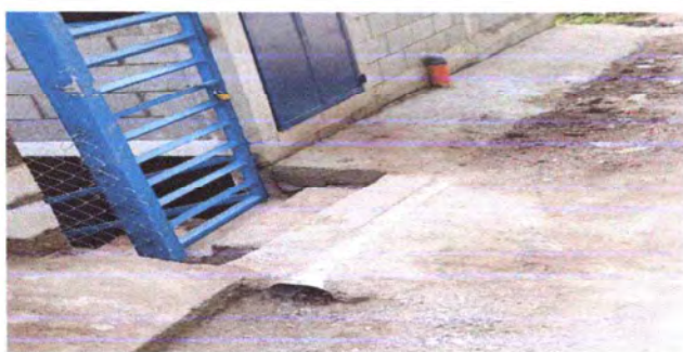
Foto 5: CUNETA DE CONCRETO
