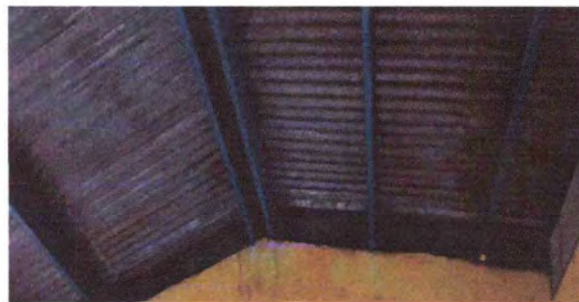
Foto 2: ESTRUCTURA DE TECHO
