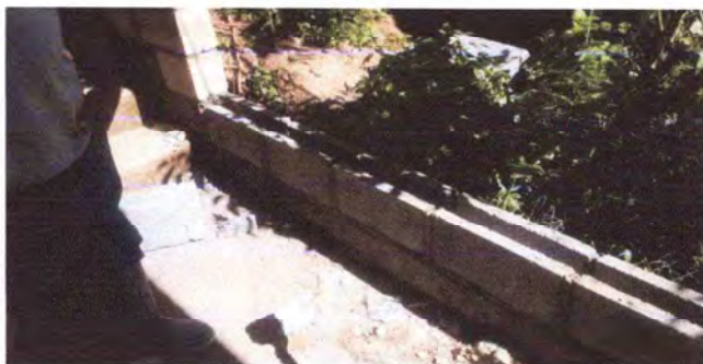
Foto 3: CERCO O MURO PERIMETRAL
