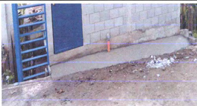
Foto 5: CUNETA DE CONCRETO
