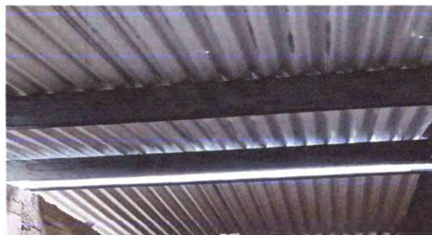
Foto 2: ESTRUCTURA DE TECHO
