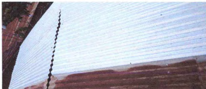
Foto 1: CUBIERTA DE LÁMINA
