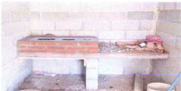
Foto 1: REPARACIÓN O SUSTITUCIÓN DE AREA DE COCINA
