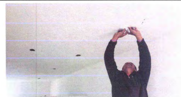
Foto 6: REPARACIÓN DE SISTEMA ELÉCTRICO
