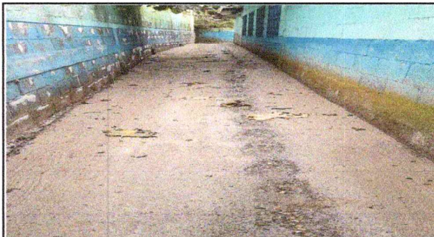
Foto 4: CUNETA DE CONCRETO TERMINADA
