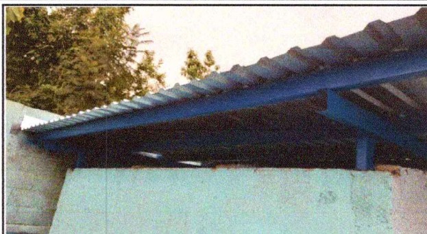
Foto 2: SE OBSERVA ESTRUCTURA DE METAL SOLDADA PINTADA Y INTALADA
