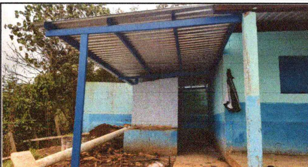
Foto 1: SE OBSERVA LAMINA INSTALADA
