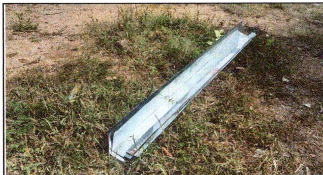
Foto 3: CANALES DOBLADOS LISTOS PARA INSTALARSE
