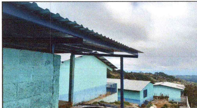
Foto 2: SE EVIDENCIA ESTRUCTURA DE METAL
