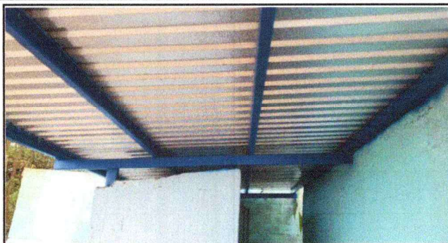
Foto 1: SE OBSERVA LAMINA EN PROCESO
