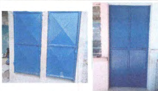
Foto 4: INSTALACIÓN DE PUERTA DE BAÑO FINALIZADO, REPARACIÓN Y MANTENIMIENTO DE PUERTAS DE AULAS FINALIZADO
