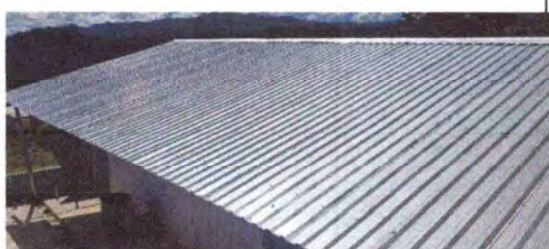
Foto 1: CAMBIO DE LÁMINA ALIZINC FINALIZADO
