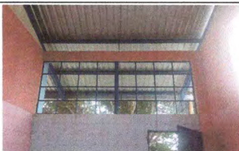
Foto 3: INTALACIÓN DE VENTANAS FINALIZADO
