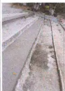
Foto 8: SUSTITUCIÓN DE LOSA DE PATIO EN PROCESO
