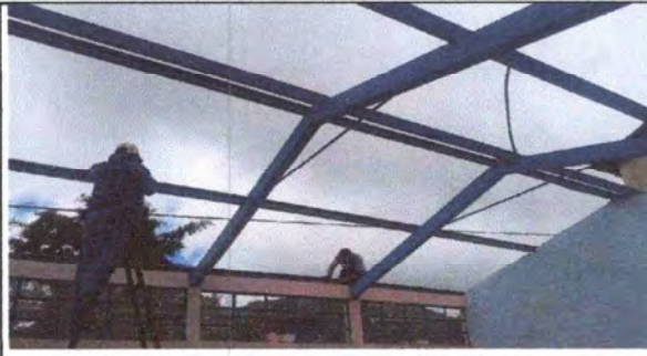
Foto 2: MANTENIMIENTO DE ESTRUCTURA METÁLICA EN REPARACIÓN
