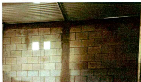
Foto 2: paredes de cocina remodelado
