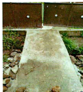
Foto 4: remodelacion de losa de patio
