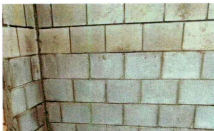
Foto 3: paredes de cocina terminadas
