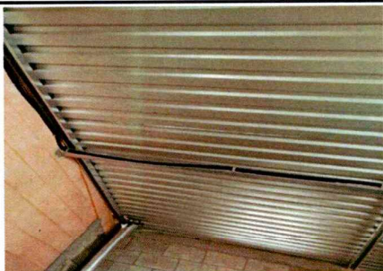
Foto 1: techo de cocina remodelado
