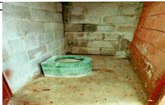
Foto 6: remodelación de sanitario
