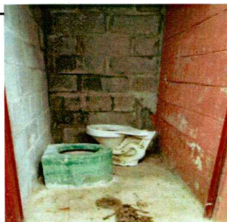
Foto 6: renovación de sanitario
