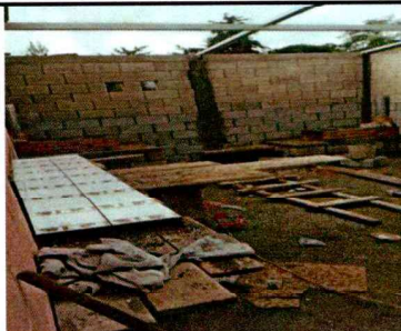
Foto 1: renovación de techo de cocina
