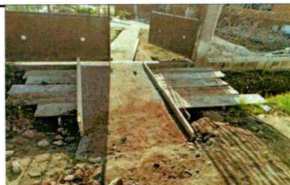
Foto 4: renovación de patio
