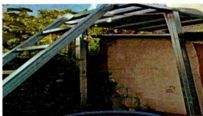
Foto 5: renovación de depósito de agua
