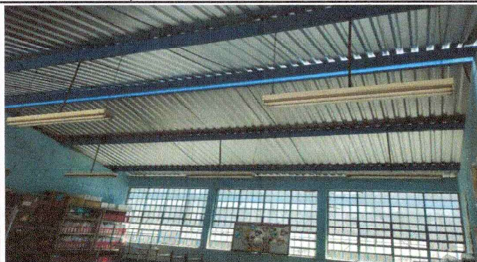
Foto 1: Sustitución y cubierta de lámina (calibre 26)
