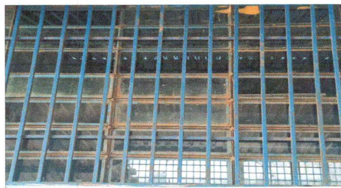
Foto 6: Reparación de ventanales (sustitución de vidrios)
