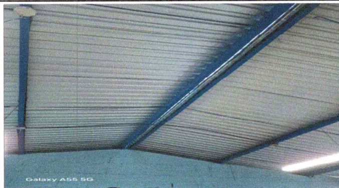
FOTO 2: Reparación de estructura del techo
